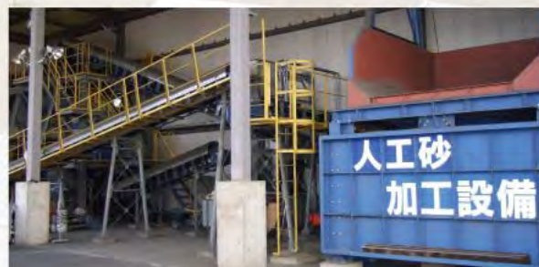
人工砂加工設備
