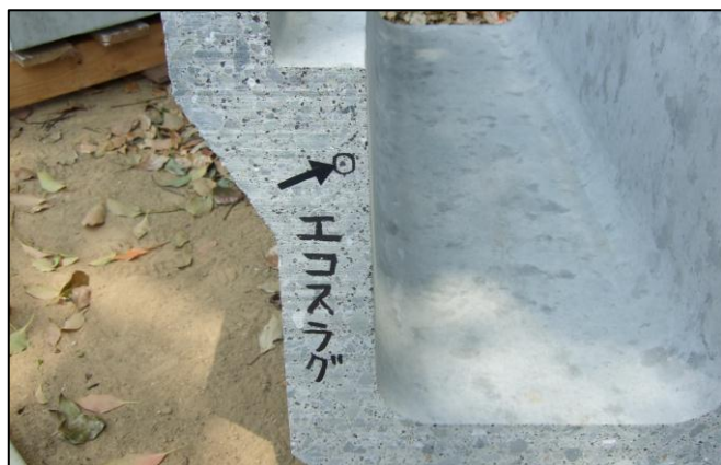
溶融スラグ使用コンクリート製品
