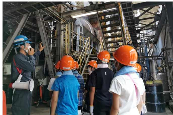
溶融炉ロータリーキルンを見学。下から見上げるとその大きさに圧倒されます。
