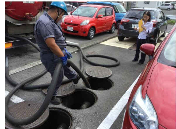
(株)群桐産業 作業立会審査（分離槽清掃）
