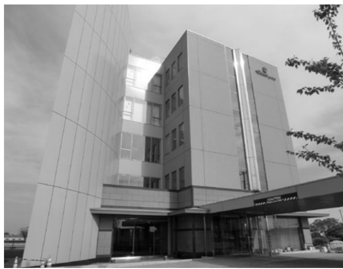
今年4月に完成した本社・営業本部の外観
