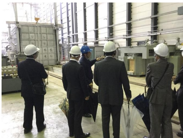
固定床炉（2号炉・3号炉）見学
