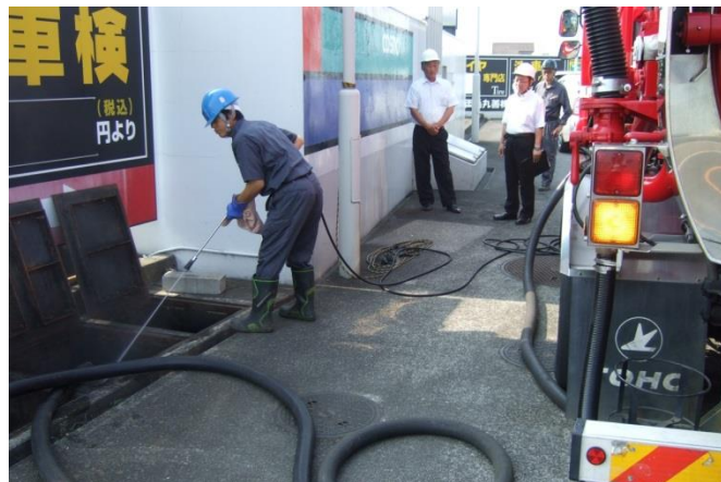
作業立会審査（分離槽清掃）
