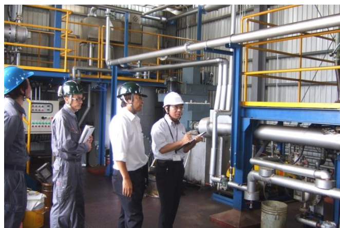
群桐エコロ(株) 油水分離施設審査
