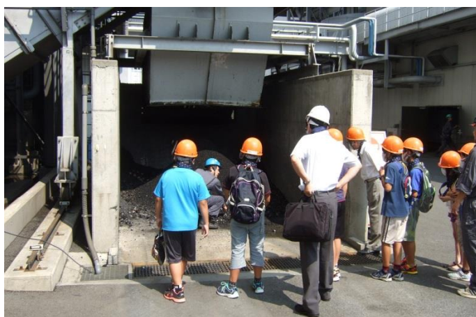
排出直後の熔融固化物。ここから加工設備に送られ人工砂になります。
