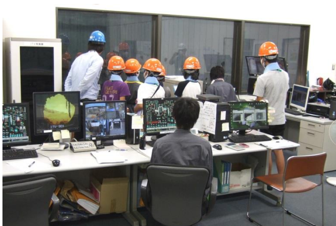
施設管理をしている中央操作室にて。先程のクレーンもここで操作しています。
