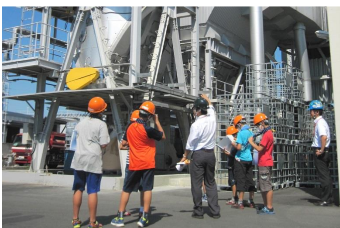
燃焼ガス(煙)がこのバッグフィルターを通ることで、無害な水蒸気となって排出されます。
