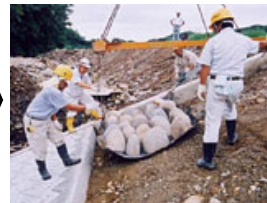
川岸に敷き詰め
