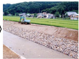
護岸工事施工
